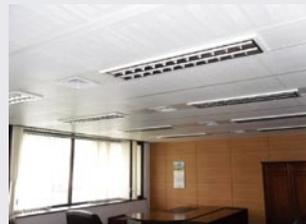
다기능 조립식 복사패널시스템 PILOT TEST 적용
