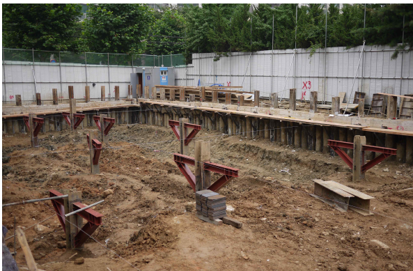
<그림 1> 가설 첩골기둥 및 첩골브라켓
