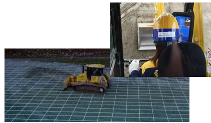
[ICT중장비에 의한 시공]
